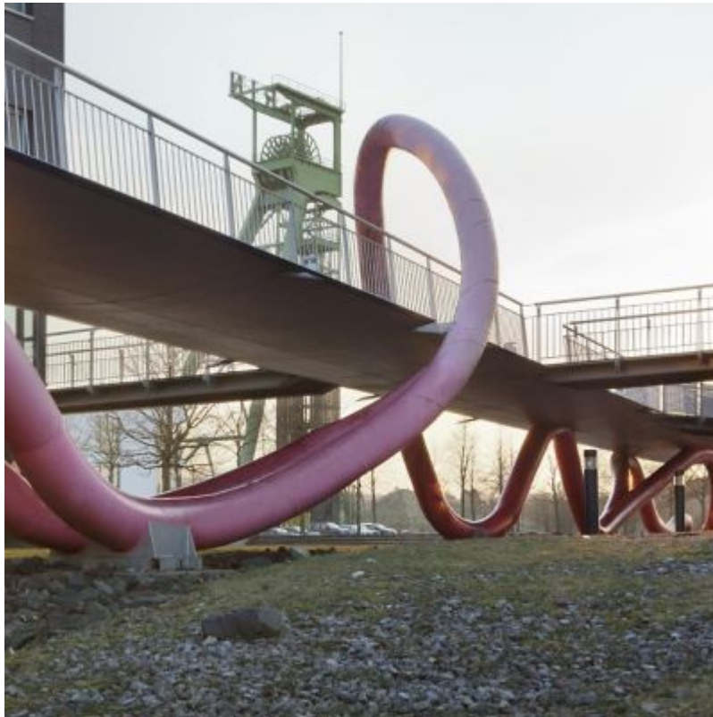
Brücke in Castrop-Rauxel von S. Polónyi. Foto: Claudia Dreyse
