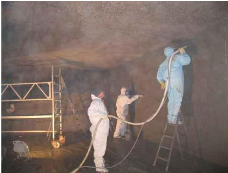
Nassspritzmörtel top 300 von epasit wird aufgebracht
