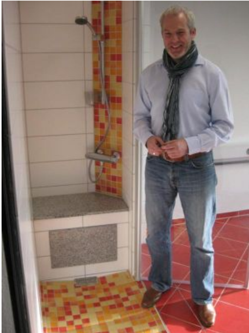
Barrierefrei auf allen Etagen: Geschäftsführer Ulrich Blome mit der Dusche "Easygo Plus".
