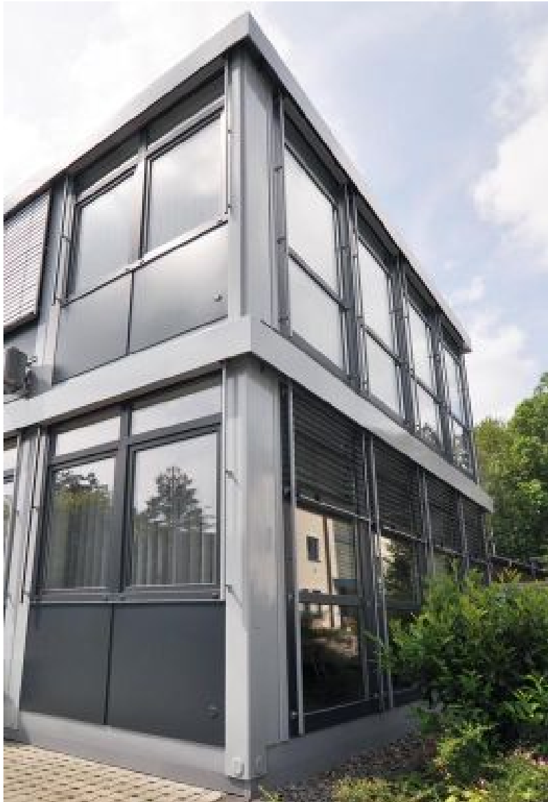
Gebäude aus hochwertigen PLUS-Containern. Nichts erinnert an herkömmliche Containeranlagen
