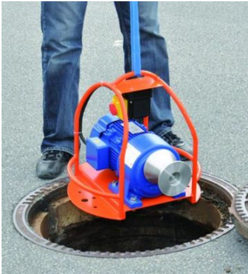
Einfache Kabelverlegung mit Kabelwinde 400 V spart Zeit und Kraft
