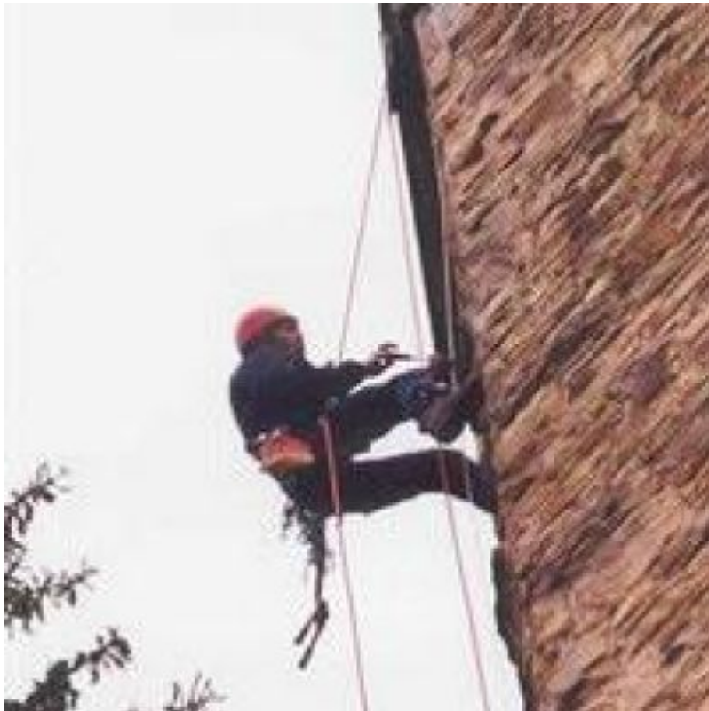
Blitzschutzmontage durch einen Mitarbeiter der Gsar mbH
