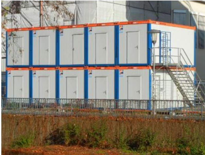
Bei der Bebauung des Südhofes der Universität Köln dienen HKL Raumcontainer als funktionale Aufenthaltsräume.
