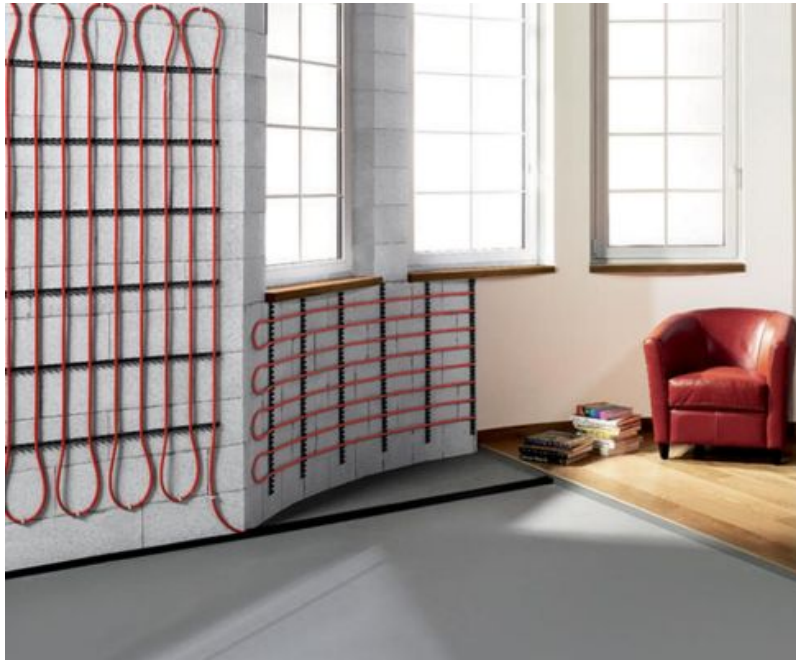
Fuß- und Wandheizungen sorgen durch Strahlungswärme für ein angenehmes Raumklima. Foto: BVF
