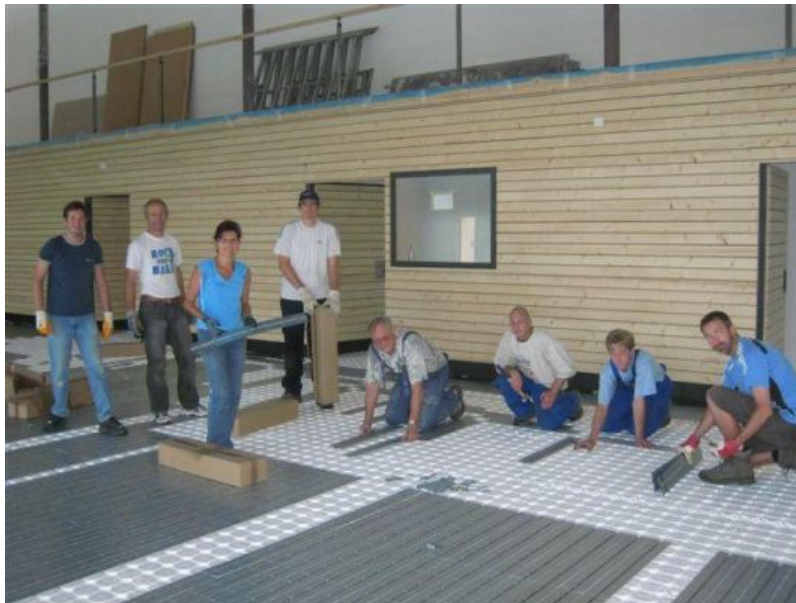
Einfach und schnell zu verlegen: das Trockenbausystem von Schütz Energy Systems.
