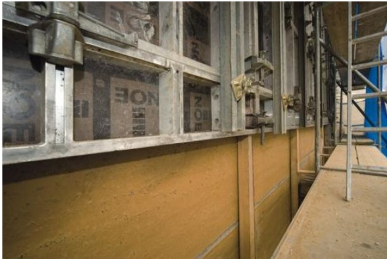
„Kletterschalung“ NOEalu L. Die NOEalu L kletterte mit und wurde nach unten durch Kanthölzer abgestützt.
