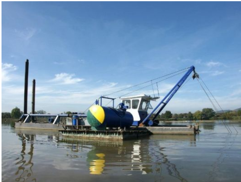
Die Baggerarbeiten im Werratalsee sollen noch bis Mitte Oktober andauern.
