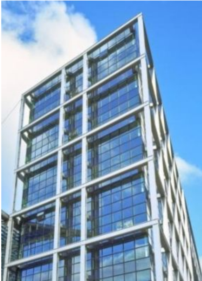
Lehrter Bahnhof, Berlin Architekt: gmp Architekten Foto: Engelhardt Sellin, München
