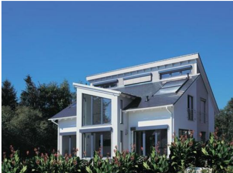
Besonderheit von Top Line 125: der verglaste Erker, der für Helligkeit und Atmosphäre sorgt. Bild: tdx/ Haas Fertigbau
