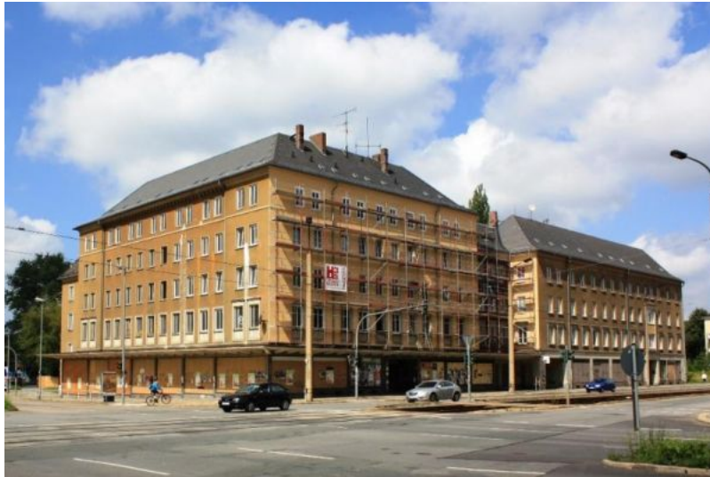
Ansicht Reitbahnstraße 84 Ecke Bernsbachplatz 5/6 in Chemnitz
