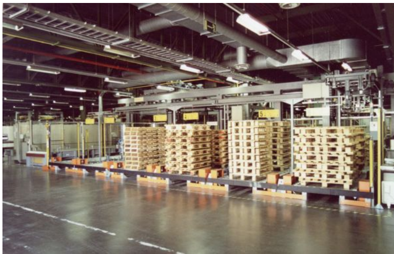
MHPS - Übersicht. Bereitstellung unterschiedlicher Palettentürme (verschachtelt)
