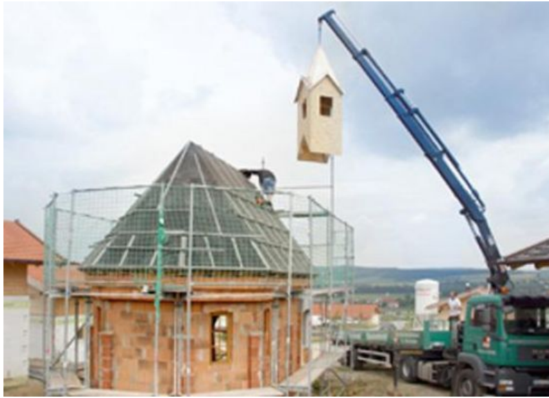
Sogar eine eigene Kapelle bekommt die neue Ferienanlage Vital Camping Bayerbach. Foto Vital Camping Bayerbach
