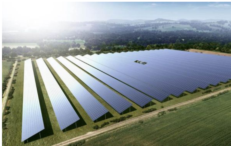
Die 2.0 MegaWattBlöcke lassen sich zu einem beliebig großen Solarkraftwerk kombinieren.
