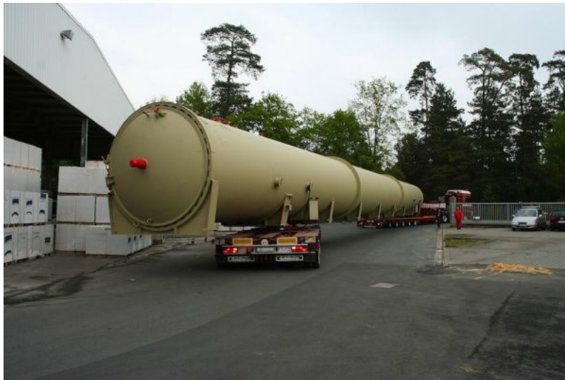
Anlieferung und Montage des neuen Härtekessels am PORIT - Standort Rodgau.
