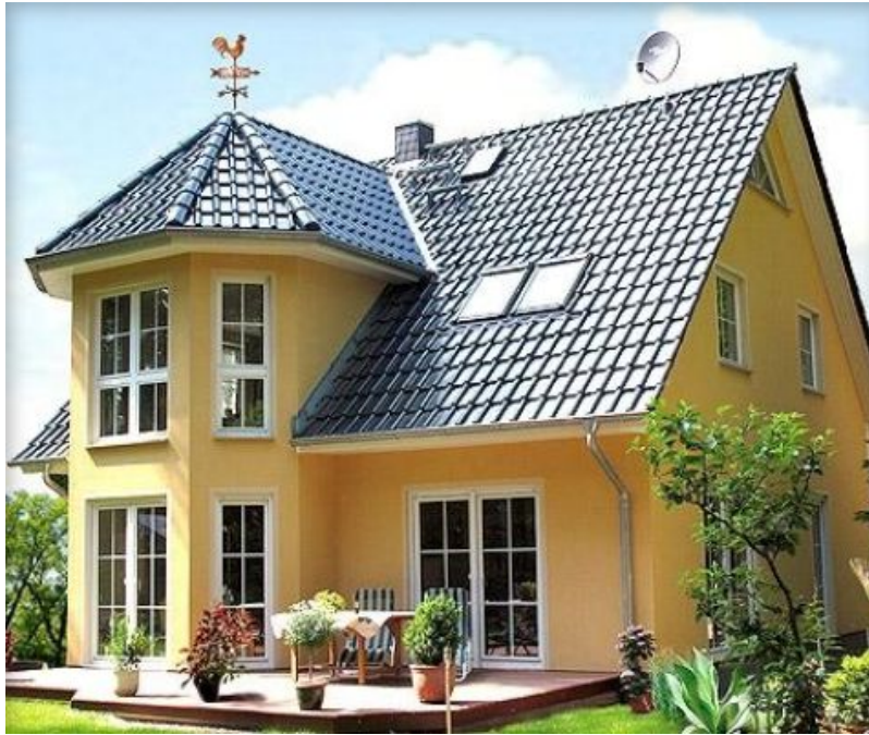
Turmhaus 152. Foto: Roth-Massivhaus
