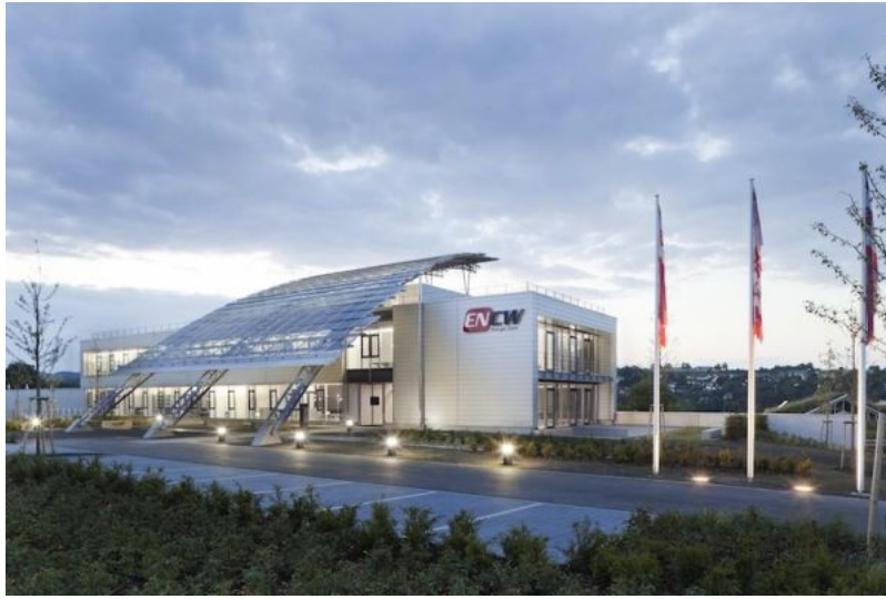
Mit modernster Photovoltaik: Die Zentrale der ENCW
