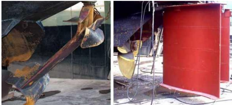
Ruderanlage Vorher - Nachher
