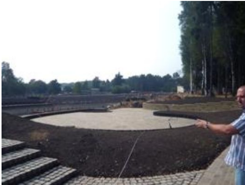
Teil des Areals mit bereits teilweise fertiggestellten Außenanlagen
