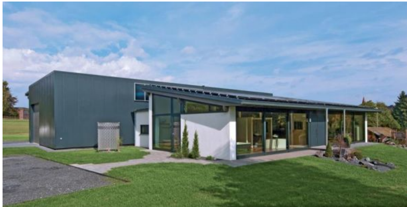
Null-Emissions-Gebäude der Zirkelbach Bad.Heizung.Solar GmbH
