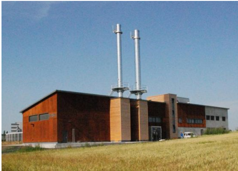
Zentrales Technikgebäude der Unterföhringer Geothermie: Die Energiezentrale
