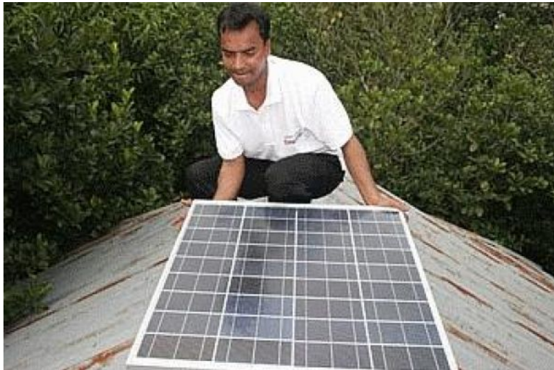
Aufbau eines Solarpanels auf dem Dach einer Hütte in Bangladesch - Andheri-Hilfe
