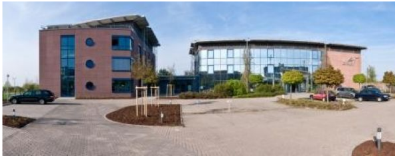
Neubau (links) und Bestandsgebäude bilden den Ibykus-Campus.
