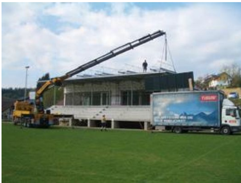
Die Montage der Kollektoren am Dach des Sportplatzes in Zusammenarbeit vom TiSUN Kranmontageteam und den Installateuren der Firma Wurm aus Königswiesen
