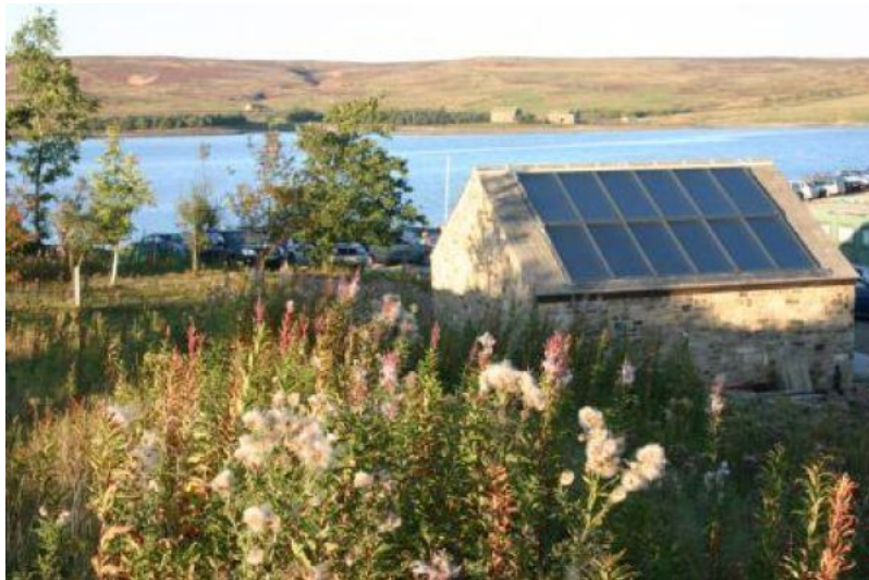
TiSUN Großflächenkollektoren FI ästhetisch im Dach des Lagerraumes vom Segelklub integriert
