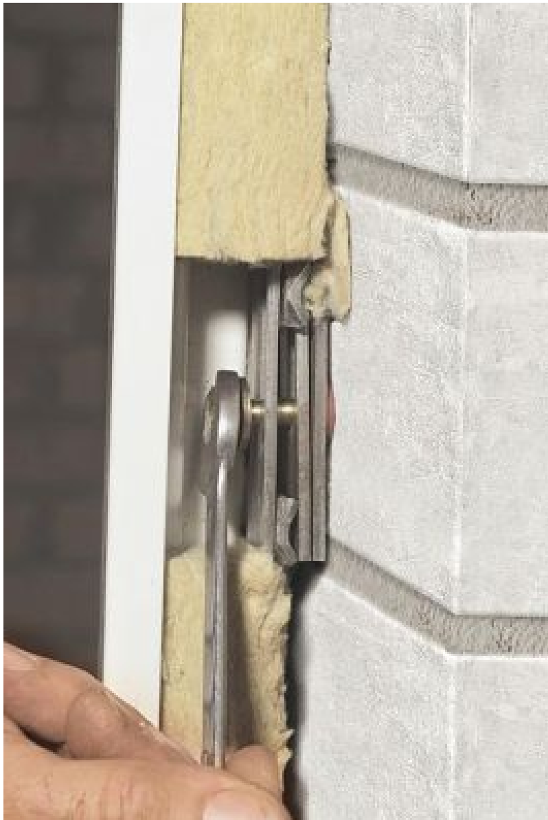
Unsichtbare Schraubmontage der Zargen ist attraktiv und einfach. (Foto: Novoferm Riexinger)
