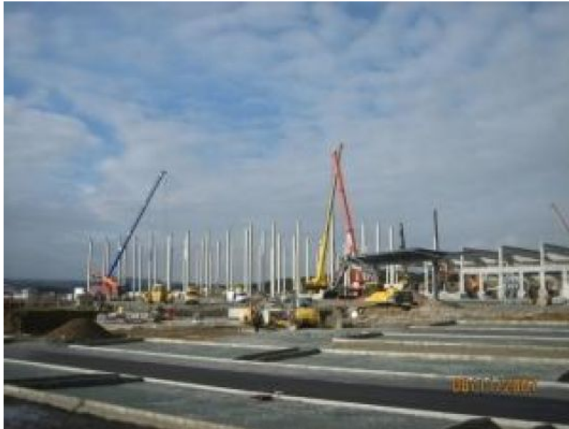
Fertigteilmontage (Stützen) im Bereich der Hochregallager
