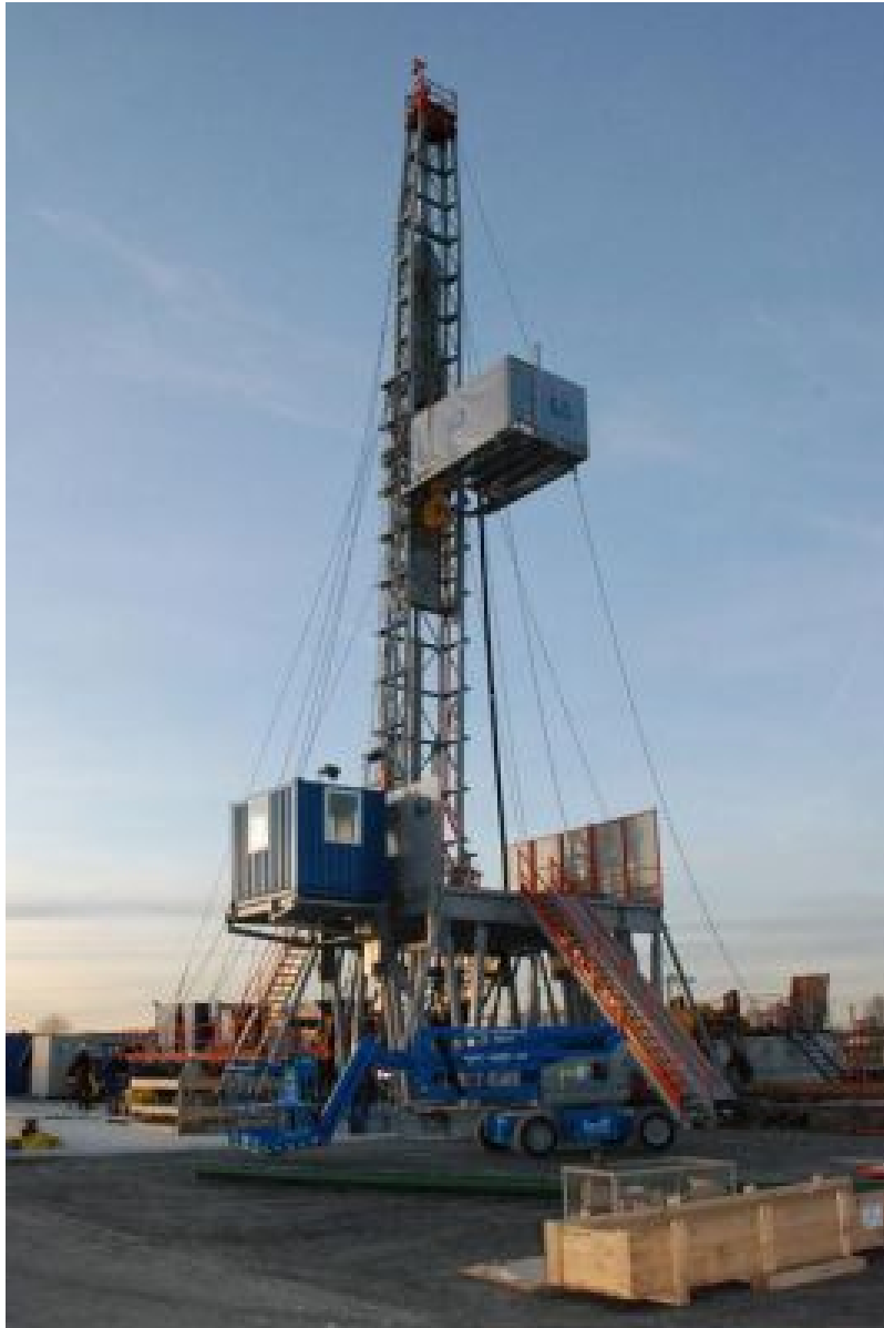
Die Bohranlage MR 8000 auf dem Unterföhringer Geothermie-Gelände
