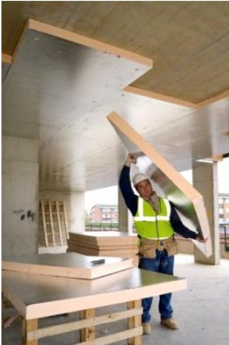
Einsatz von Resol Hartschaumplatten bei Kellerdeckendämmung
