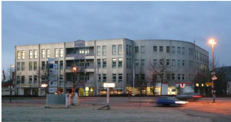
Büro- und Geschäftshaus in der Hähnlehofstraße 5 in Ravensburg, Foto: Johannes Kaut
