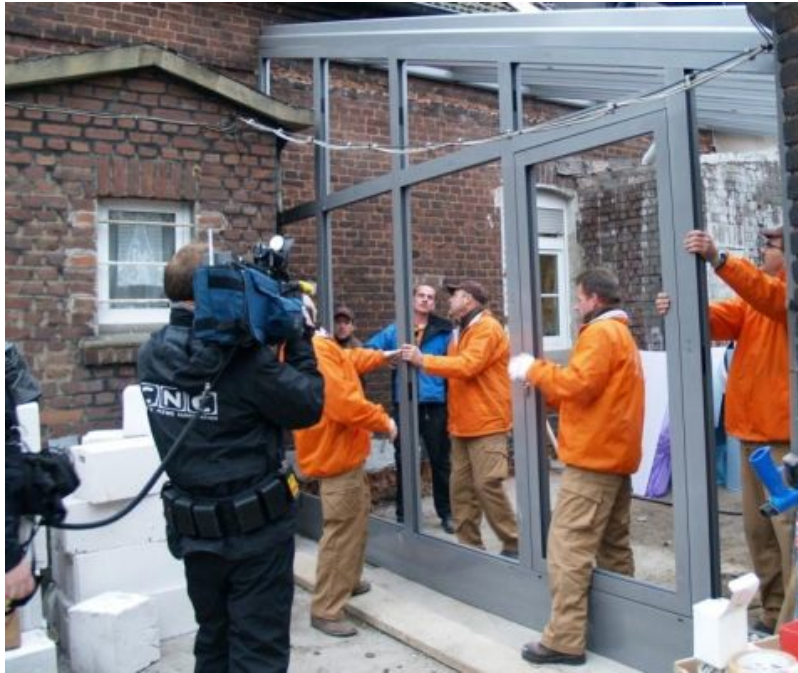
Wintergarten Montage vor laufenden Kameras
