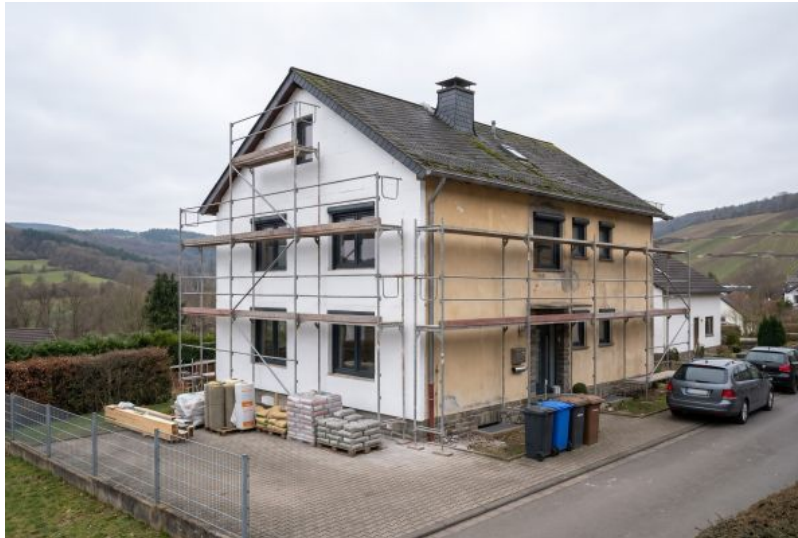
Symbolbild: Einfamilienhaus mit Gerüst bei der Fassadensanierung
