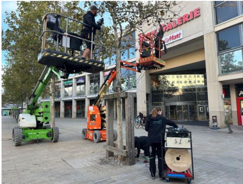
Anbringung und Kontrolle der Winterbeleuchtung
