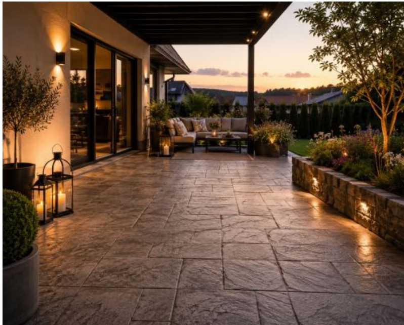
Betonveredelung mit Prägebeton in Grau (Römischer Verbund)
