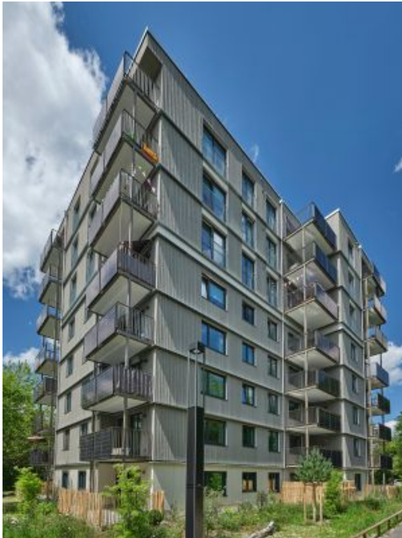
Sanierung und Aufstockung München Allach
