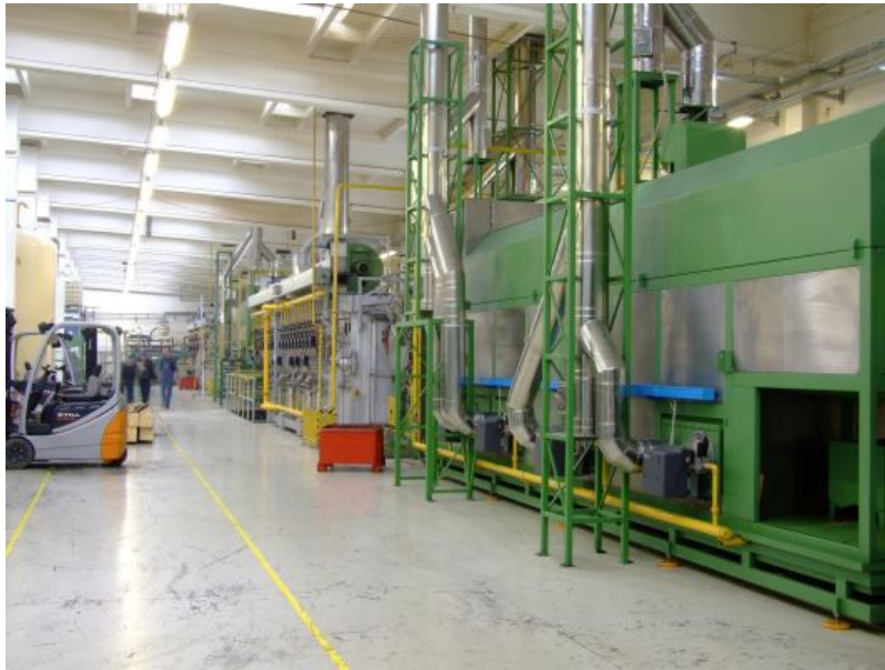
Lager eines Produktionsbetriebs
