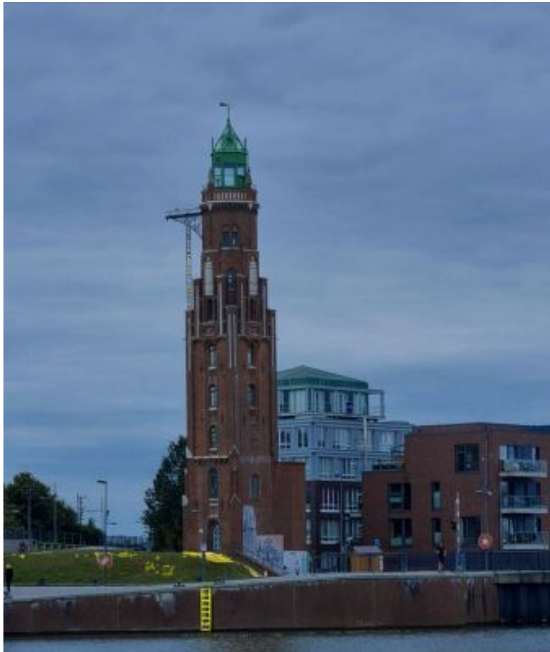
Neue Rettungsleiter „LifeLadder“ erhöht die Sicherheit im Hafen Bremerhaven
