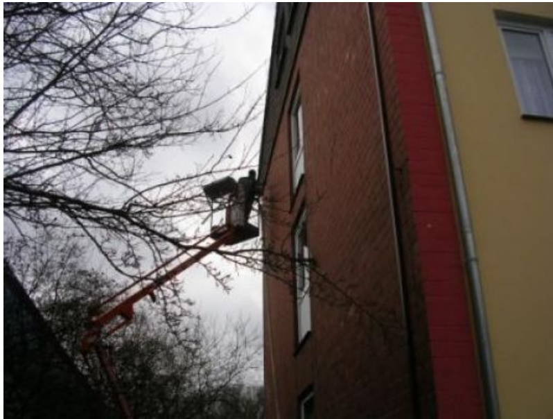
nbringen von Nanogel in zweischaliges Mauerwerk
