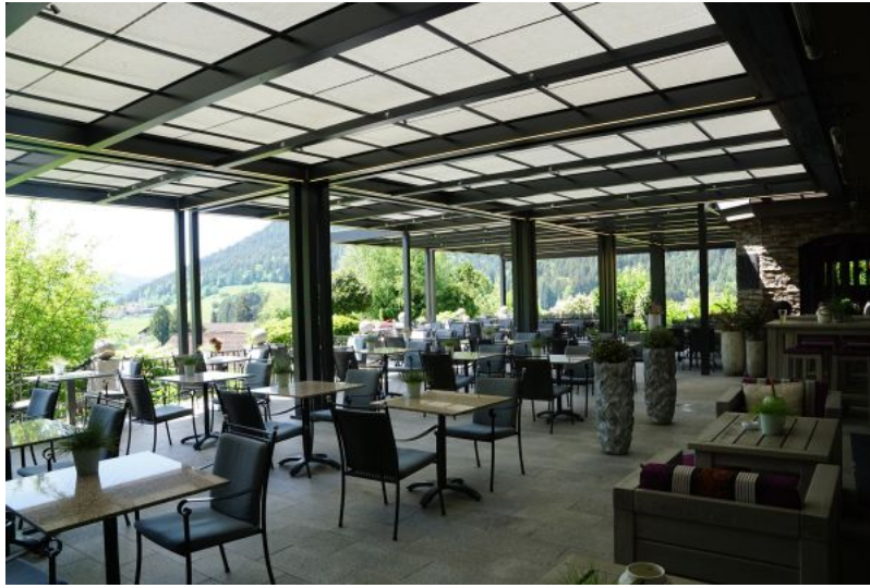
Die Außenterrasse des Heselbacher Hofes wurde mit acht „markilux markant“ Anlagen überdacht.
