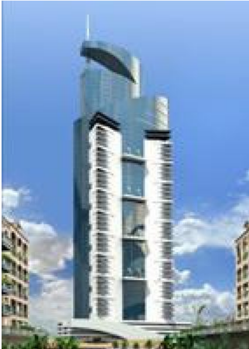
Beispiel Tower aus Dubailand
