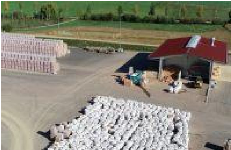
In der Recyclinganlage von LB werden Ziegelbruch und Dämmstoffe sauber getrennt. (Foto: Leipfinger-Bader)
