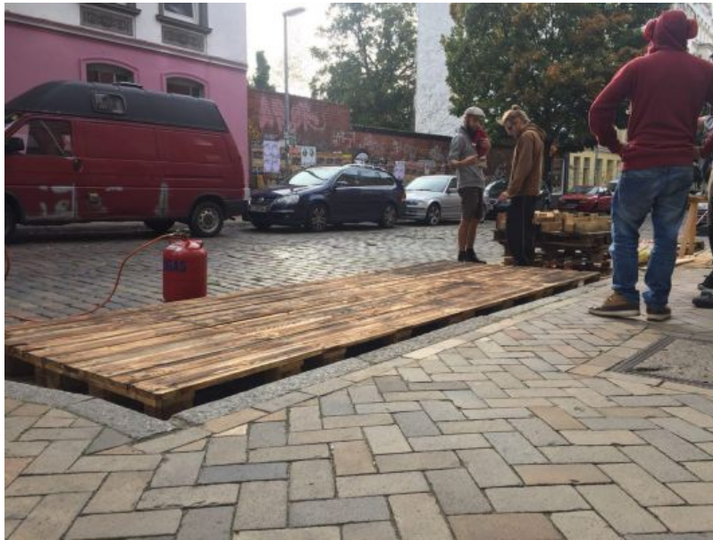
Bau eines Parklets
