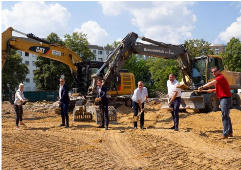
Spatenstich der Partner- und Baufirmen zum Baustart der Kap-herr Residenz in Dresden-Prohlis
