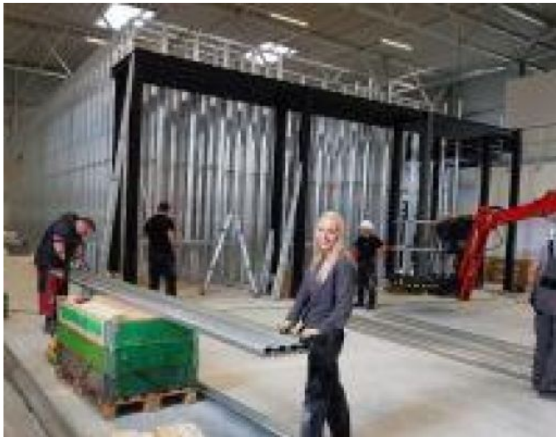
Die kompetenten Mitarbeiter von AM-Automation sorgen für eine reibungslose Montage.
