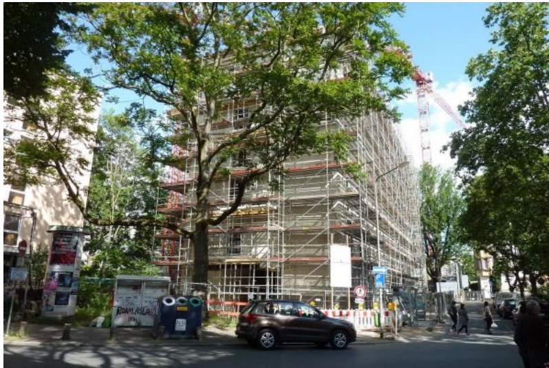
Rohbau Kita und Studentenwohnheim Rohmerplatz in Frankfurt am Main, Bild: BSMF
