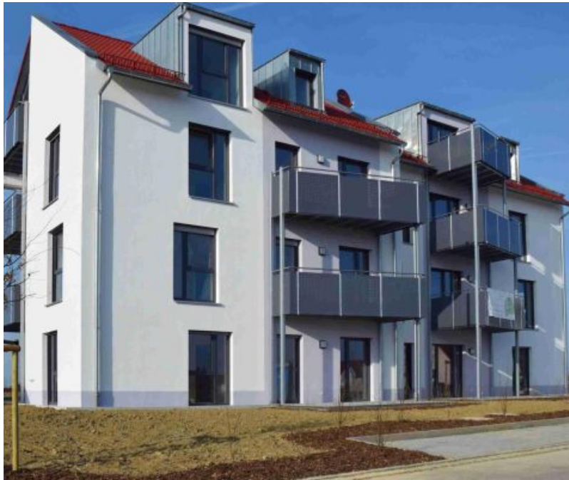
Viergeschossiges Mehrfamilienhaus in Holzbauweise mit 8 Wohneinheiten - Quelle MohrHolzhaus GmbH
