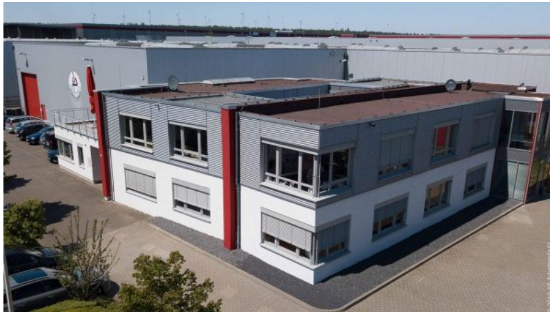
AS Arbeitsschutz startet in die Erweiterung der bestehenden Logistikkapazitäten im nordrhein-westfäl
